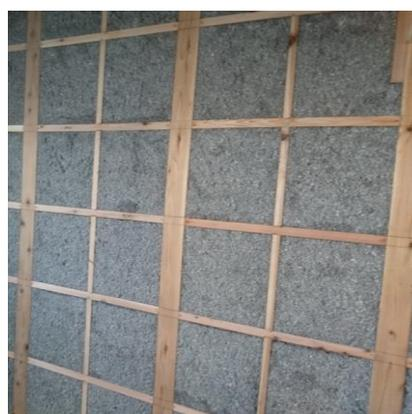
セルロースファイバー断熱材は隙間なく躯体に充填することで気密断熱とも高い品質の住まいになります。また、火災に強いことから火災保険を大幅に節約できます。
