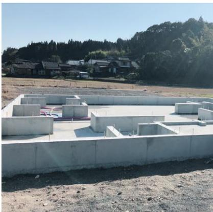
構造物からの力を地盤に伝え、構造物を安全に支える機能をもつ基礎は、床下全体にコンクリートを打ってつくる「ベタ基礎」を採用。地盤と接している部分の広い面積、家の荷重が分散され、安定した基礎です。
