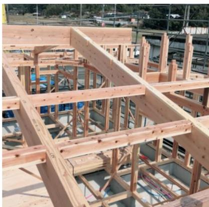
家を支える柱と梁。もっとも大切な躯体は**自然乾燥**させた**無垢材**を使用。木が持つ本来の特性を考慮して適材適所に樹種を選び、しっかりとした頑強で強固な構造躯体をつくり上げています。
