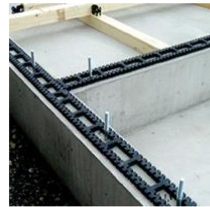
床下換気口は**基礎パッキン**工法を採用し、基礎部分の全面に通気性を確保することによって建物の寿命を延ばします。さらに見た目がスマートでデザイン性の高い家づくりが可能。
